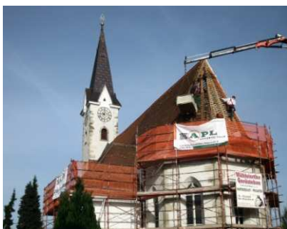
Arbeiten am Kirchendach
