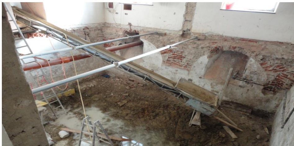
Aushub Heizung im Keller
