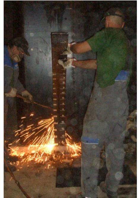
Firma Kreindl aus Freistadt beim Zerlegen der entleerten und gereinigten Öltanks
