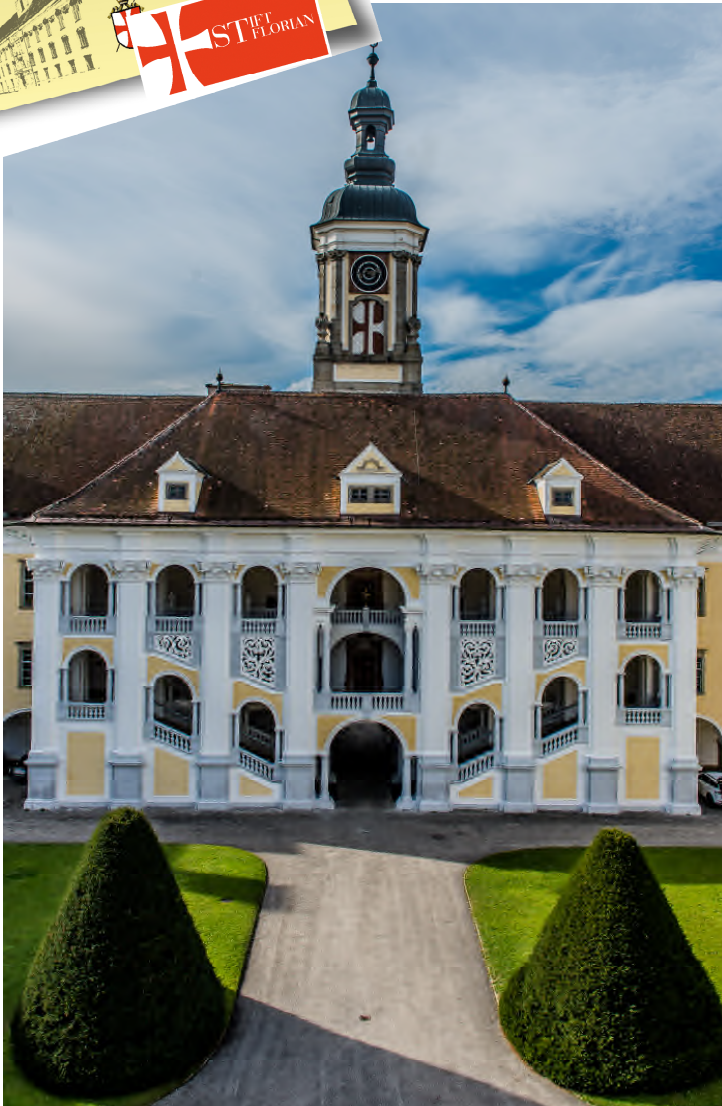
Die Kaiserstiege nach Abschluss der Restaurierungsarbeiten im Oktober 2013
