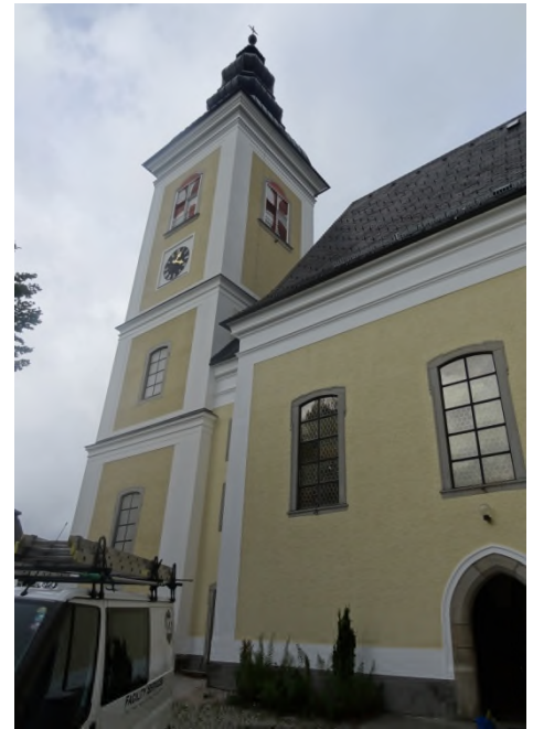
Die Fassade der Kirche von St. Peter am Wimberg wurde diesen Sommer umfassend restauriert
