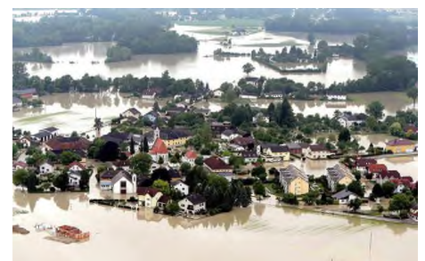
Luftbild der Überflutungen
